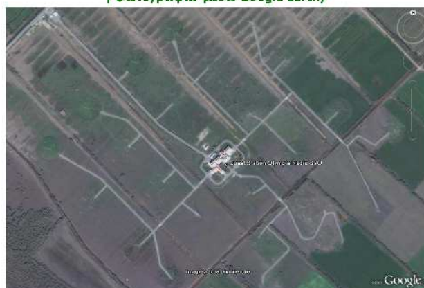
Εικόνα 2.7: ΟΛΥΜΠΙΑ ΡΑΔΙΟ (HF - Πύργος Ηλείας (Φωτογραφία μέσω Google Earth)
