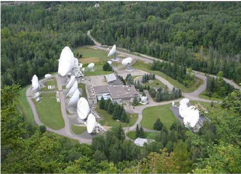
Εικόνα 5.13: Ο δορυφορικός σταθμός LAURENTIDES (CANADA) (Photo: www.wikimapia.org)
